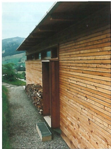
Eine offene Lärchenholzschalung bildet die Außenhaut.
